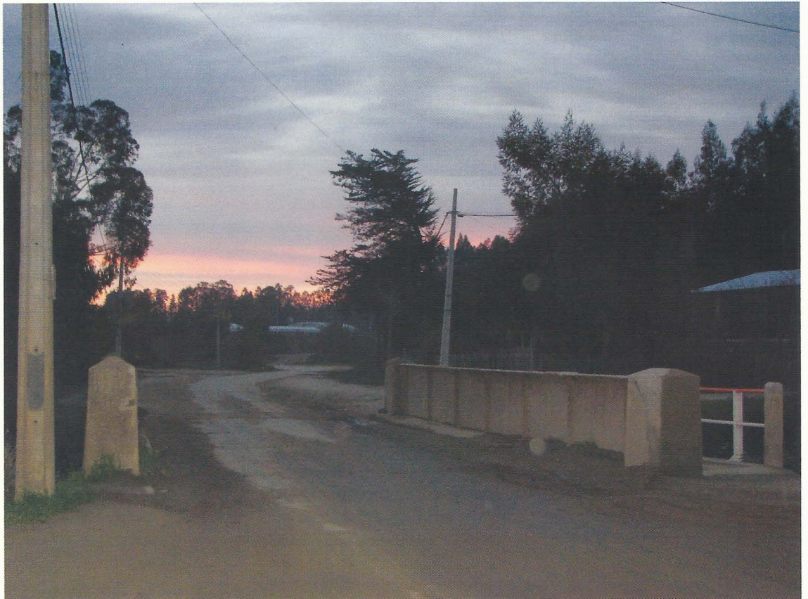
Puente, Sector Villa Los Álamos, Peñuelas.
